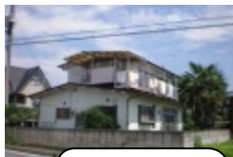
現在のシオンホーム
